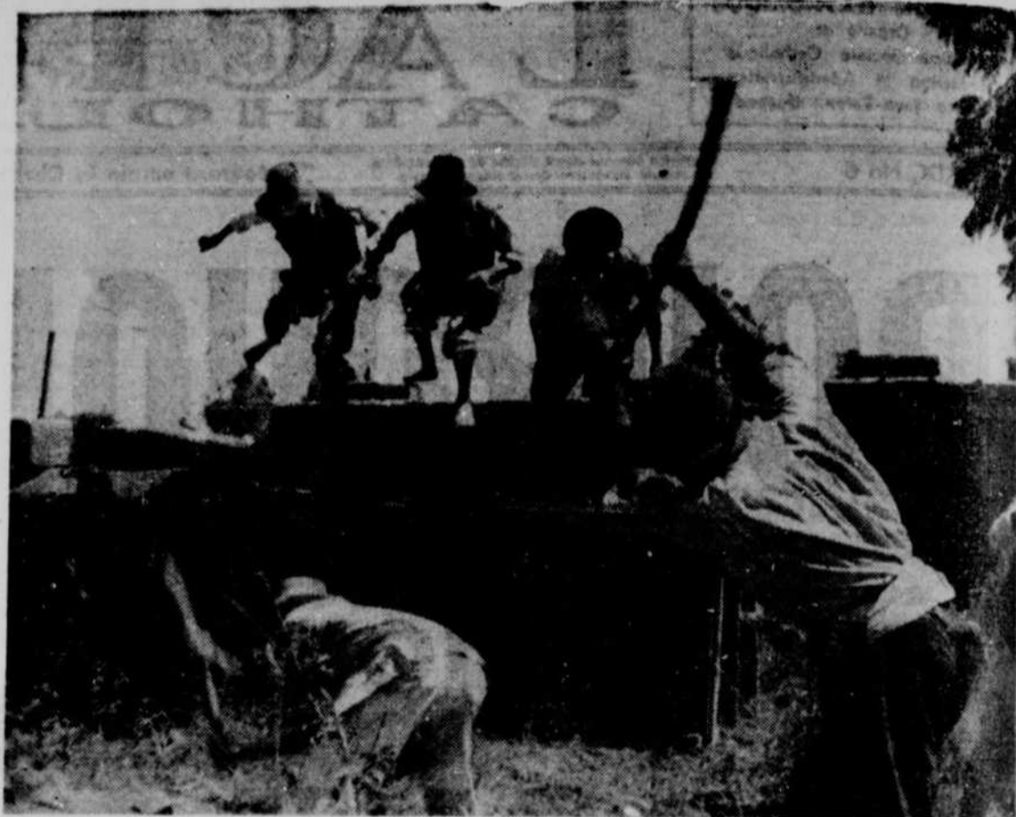
● Ces Indiens des Andes construisent une maison. C'est, en effet, en tassant, par leurs sauts répétés, la terre dans des cadres qu'ils parviennent à monter des murs suffisamment solides. L'amélioration des conditions d'existence des populations indigènes de Bolivie, de l'Equateur et du Pérou fait l'objet des efforts concertés des Nations-Unies, de l'Organisation internationale du Travail, de l'Organisation pour l'Alimentation et l'Agriculture, de l'Unesco et de l'Organisation mondiale de la Santé dans le cadre de leur programme d'assistance technique. (Photo B.I.T.)
