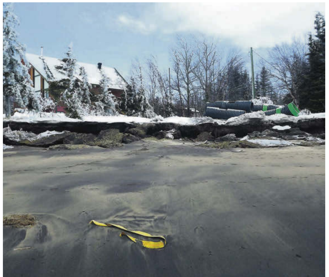
En avril 2018, deux tempêtes successives ont eu raison des rolodunes installés l'année précédente sur deux des trois sites du banc d'essai.
