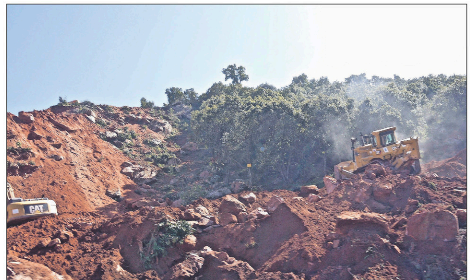
Travaux en cours sur une portion de la montagne en bordure de la route 9.
