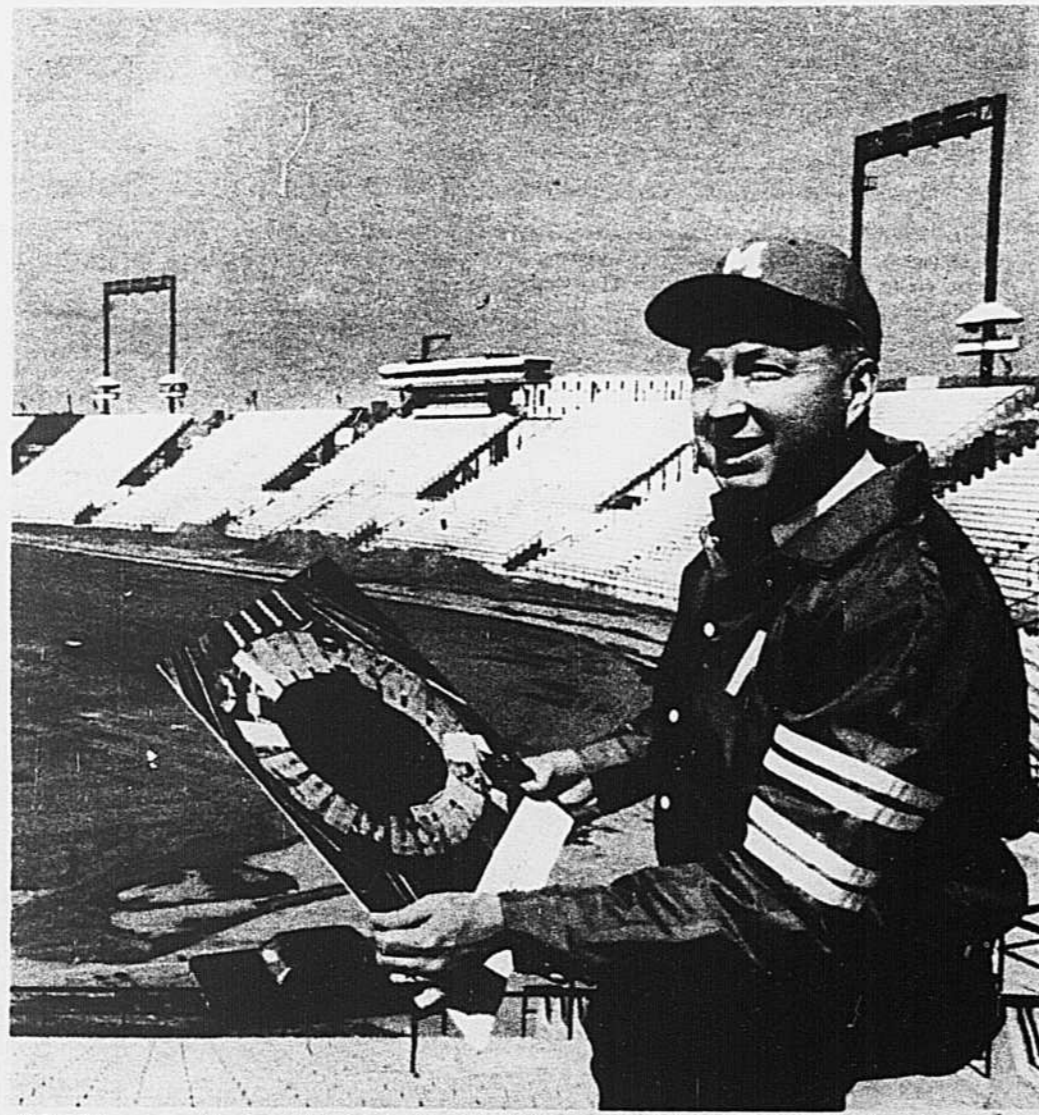
Dès l'an prochain, l'Autostade de l'Expo aura une capacité accrue de quelque 12,500 places et pourra accueillir la nouvelle équipe de baseball.
