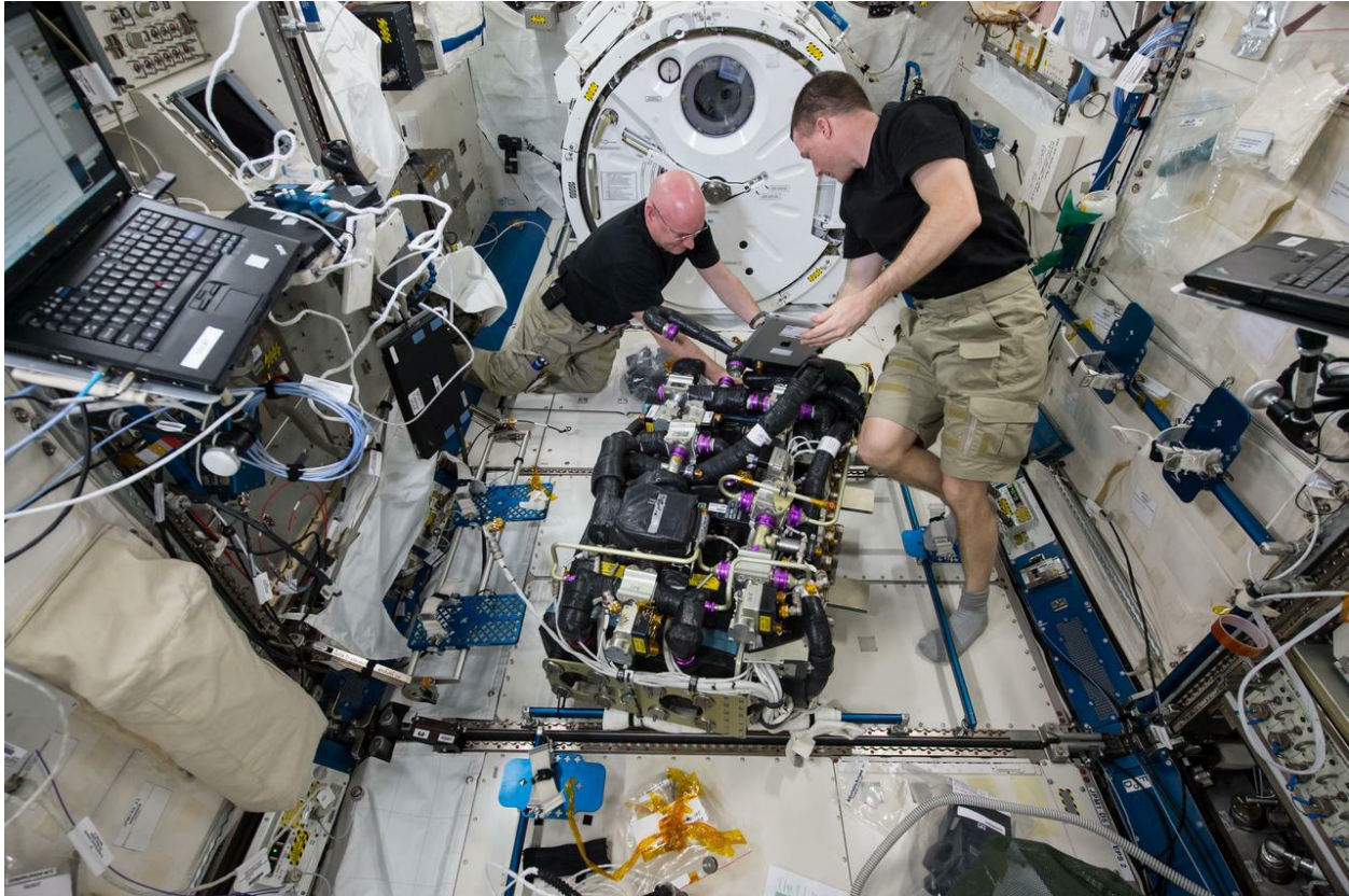
Scott Kelley et Terry Virts réparant le système de filtration de l'air de la Station spatiale: tout est si compliqué en apesanteur!
