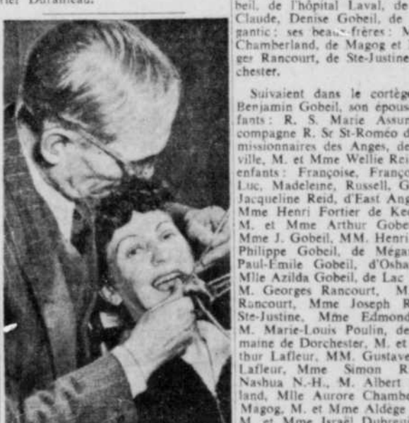
Sans douleur — Le dentiste H. Berlin, Allemand, opère une patiente au moyen du nouveau foré "carbotherm" qui, dit-il, ne cause aucune douleur. Le secret du nouveau dispositif consiste en un tube fin, qui envoie de l'acide carbonique chauffé sur la dent.
