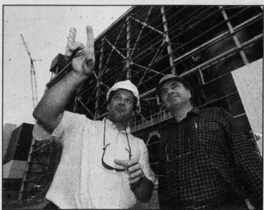
Le directeur du chantier de construction de l'usine Magnola d'Asbestos, Jean-Pierre Landry, à gauche, fait le point sur la progression des travaux en compagnie du président de l'entreprise, Michael Avedesian.
