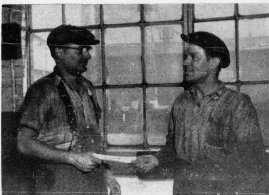
M. Egide Simard, à gauche, de l'Usine des Electrodes, a suggéré un meilleur système de communication entre les opérateurs des balances et ceux des malaxeurs de pâte à électrodes. Cette nouvelle installation qu'il a proposée réduit le trajet parcouru par ces employés au cours de leur journée de travail. M. Louis Perron, contremaître du département, a remis un chèque de $5 à l'heureux suggesteur.
