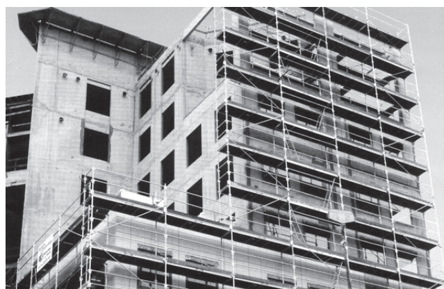
Échafaudage sur cadres métalliques européens
