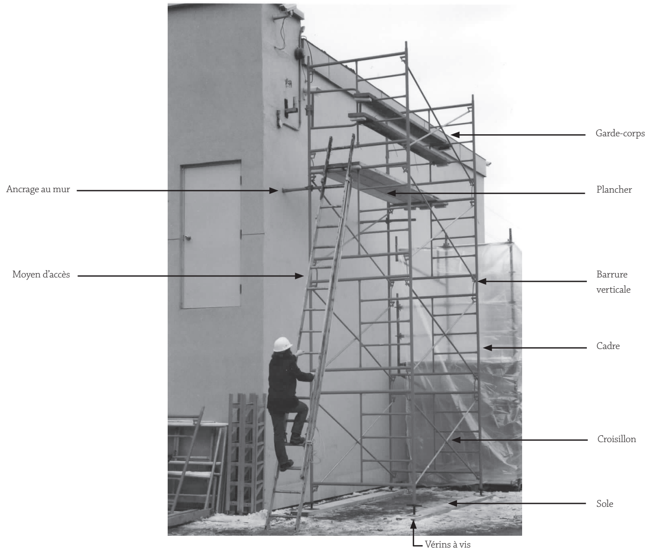
Composants des échafaudages sur cadres métalliques
