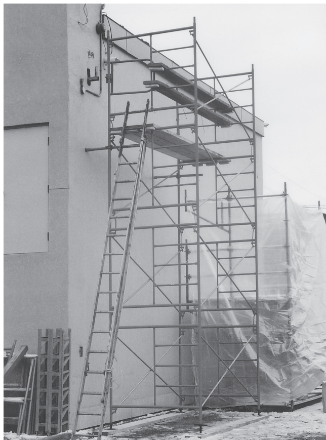
Échafaudage sur cadres métalliques traditionnels
