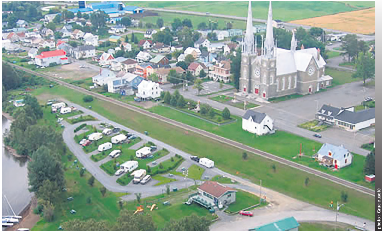
Les travaux devraient se terminer en décembre.
