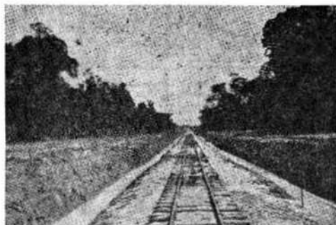
CHEMIN DE FER CONSTRUIT EN GUYANE POUR L'EXPLOITATION DU BAUXITE.
