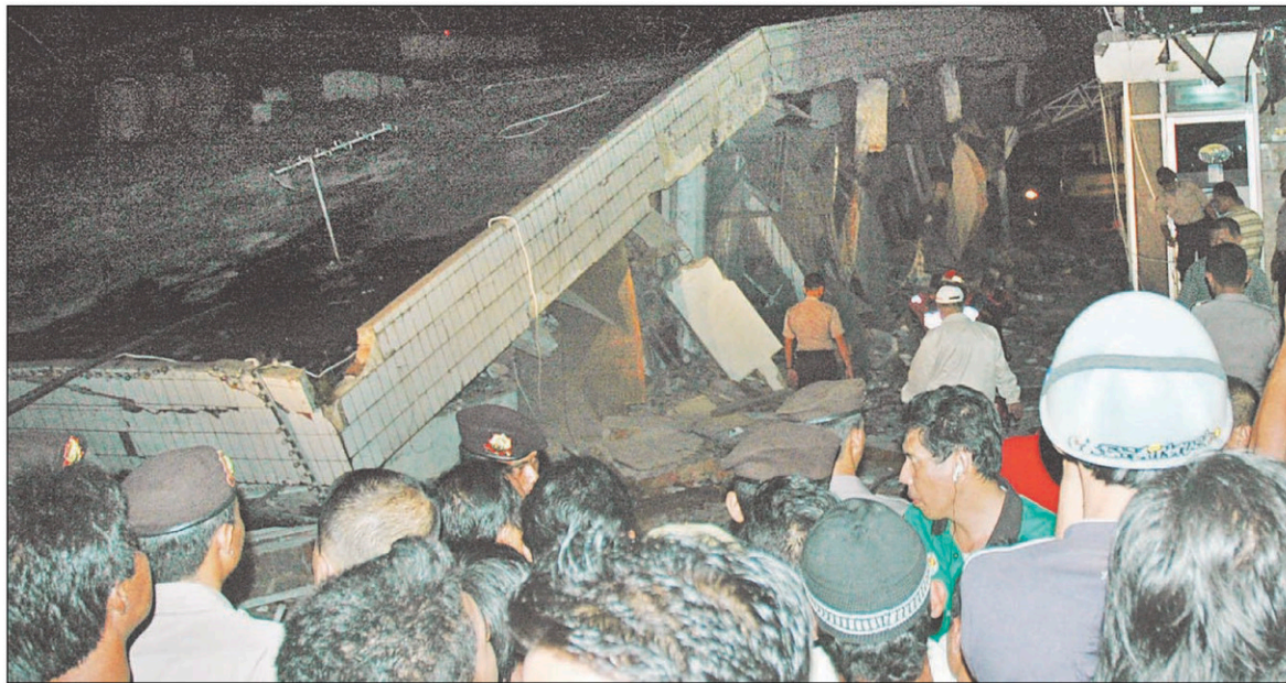
Des résidents et des secouristes regardent un immeuble effondré à la suite du tremblement de terre qui a secoué Sumatra, en Indonésie, et d'autres pays du pourtour de l'océan Indien hier.
