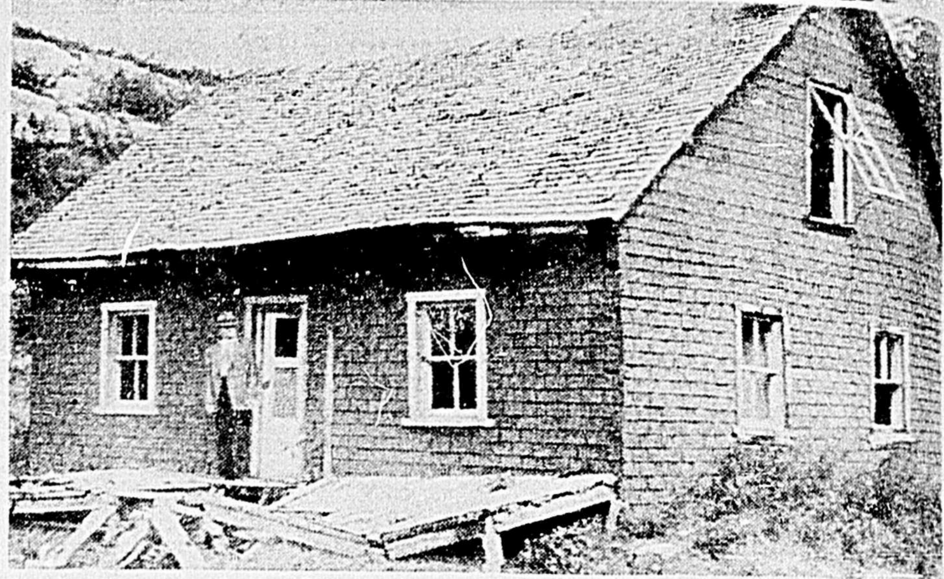
LA FERME DE VAL-MENAUD présente la diséparation la plus contrastée avec la verdoyante et puissante nature qui l'entoure. De suite par le feu en juillet 1951 les bâtiments n'ont jamais été relevés de leur ruine. Me Larouche s'est écrit: "Est-ce la main de Dieu, ou la patte du diable, ou l'erreur d'un humain qui fait brûler mes bâtiments".
