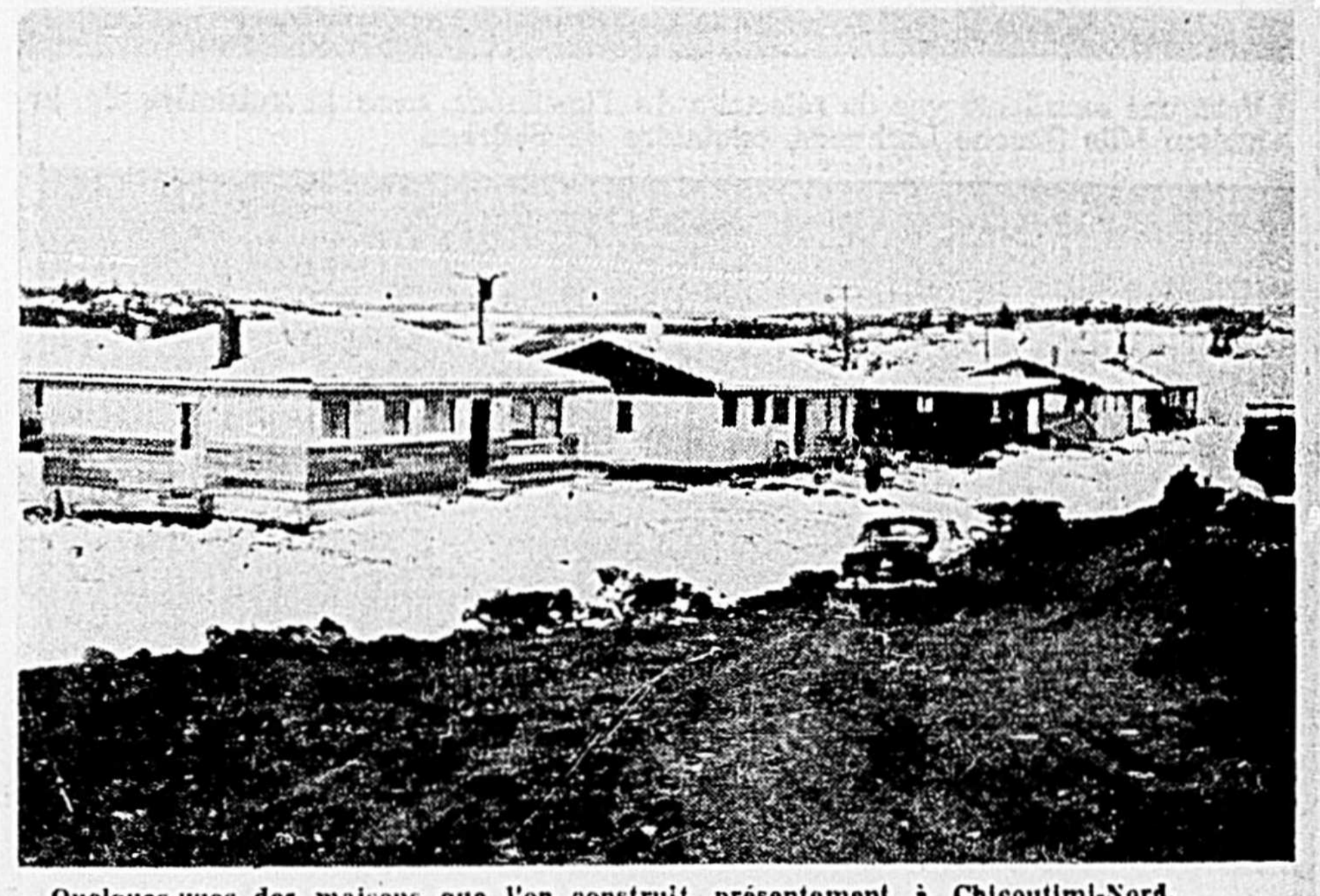
Quelques-unes des maisons que l'on construit présentement à Chicoutimi-Nord.
