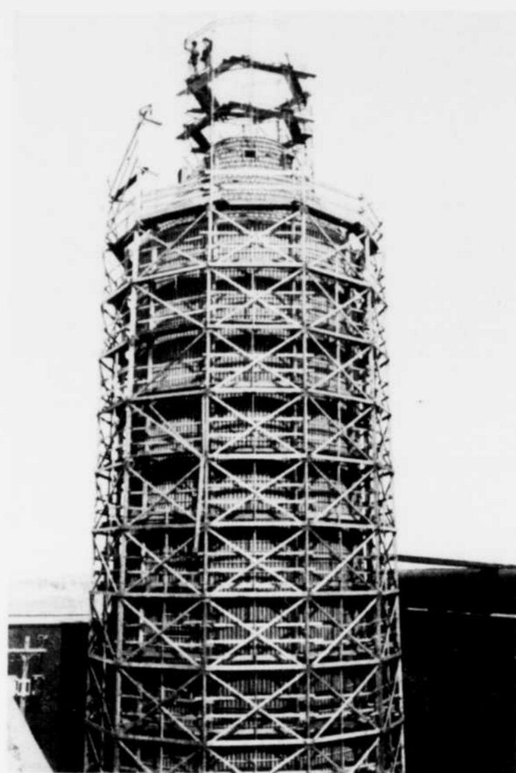
Le programme d'assainissement de l'air a permis de construire une quarantaine de ces épurateurs à lit de balles, à l'Usine Arvida. [Photo: Jean Matteau]
