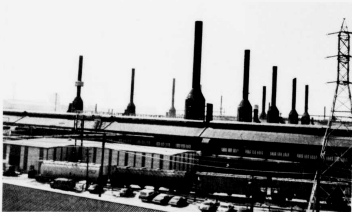
Grâce à ces épurateurs, les émissions de fluorures à l'atmosphère ont été considérablement réduites depuis 1972. [Photo: Jean Matteau]
