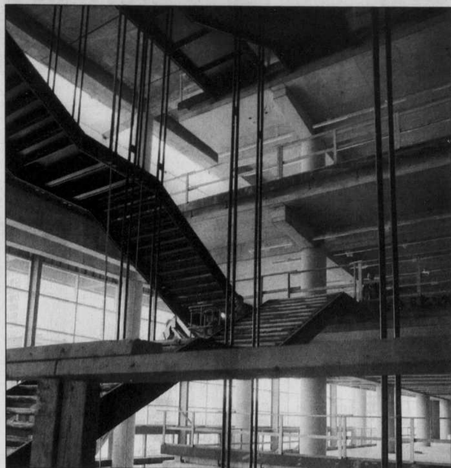
Vue de l'intérieur en construction de la Bibliothèque nationale.
