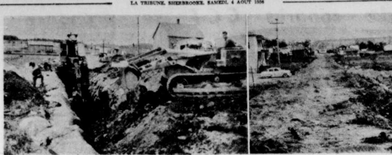
OUVERTURE D'UNE NOUVELLE RUE A THETFORD MINES — Ces deux photos illustrent l'ampleur des travaux municipaux en cours dans le quartier Bellevue, à Thetford Mines. C'est la rue Carrier que l'on est à ouvrir et à organiser avant la construction
