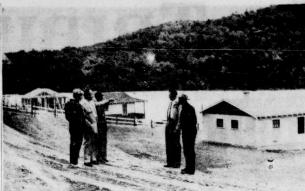
TRAVAUX GIGANTESQUES AU LAC LIPPE — Le président du club de chasse et de pêche de Coaticook explique ici à quelques membres et au représentant de notre journal les travaux immenses qui ont été faits à cet endroit depuis l'an dernier. On remarquera la route large, la chaussée élevée, l'aplanissement des terrains et les jolis chalets construits là ou, l'an dernier, ce n'était que marécage et bois mort, transformant le paysage austère et sauvage en un site agréable et habitable. On voit, de gauche à droite: MM. Lucien Rouchard, représentant de La Tribune à Coaticook; Aldé Allaire, président du club; Lucien Huot, trésorier; Adolphe Raymond et Donat Bissonnette, membres du club. (Photo studio Ross, Coaticook)
