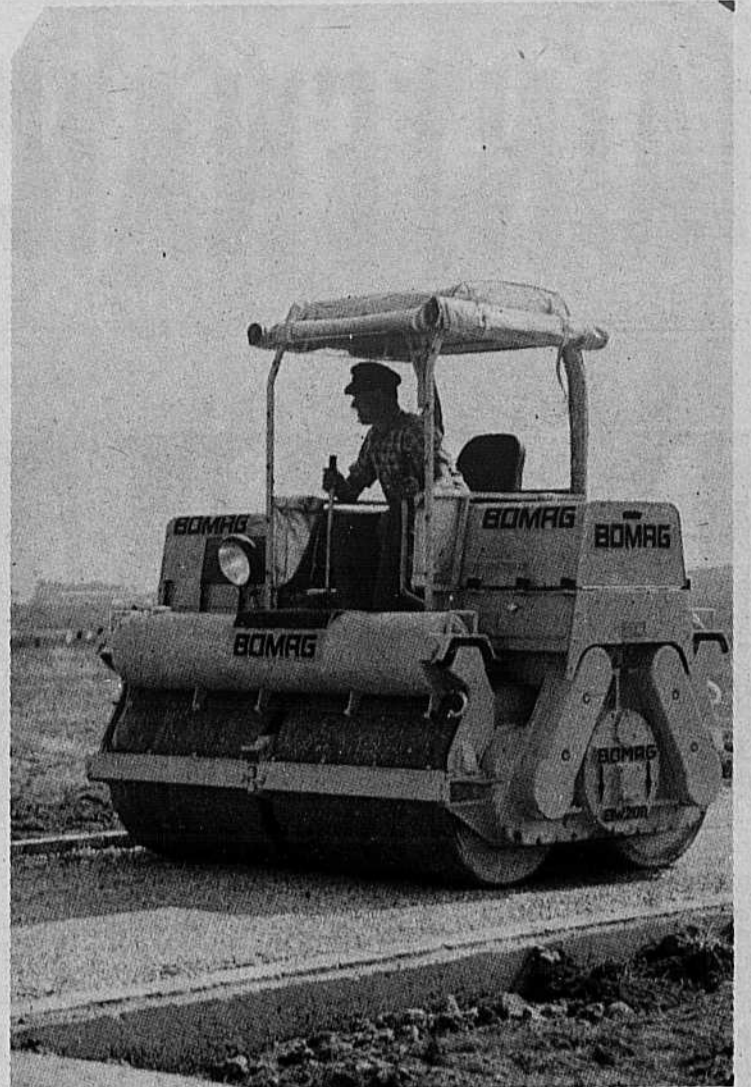
Le compactage du sol se fait au moyen des réputés rouleaux vibrants "Bomag".
