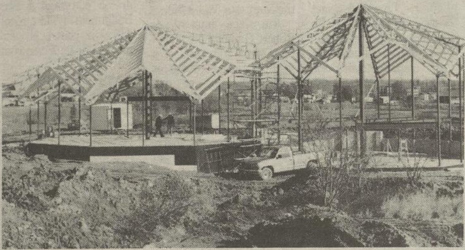
On a commencé à élever les structures du nouveau Centre d'éducation à la conservation au Parc Marie-Victorin de Kingsey Falls. L'inauguration est prévue pour août 1990.
