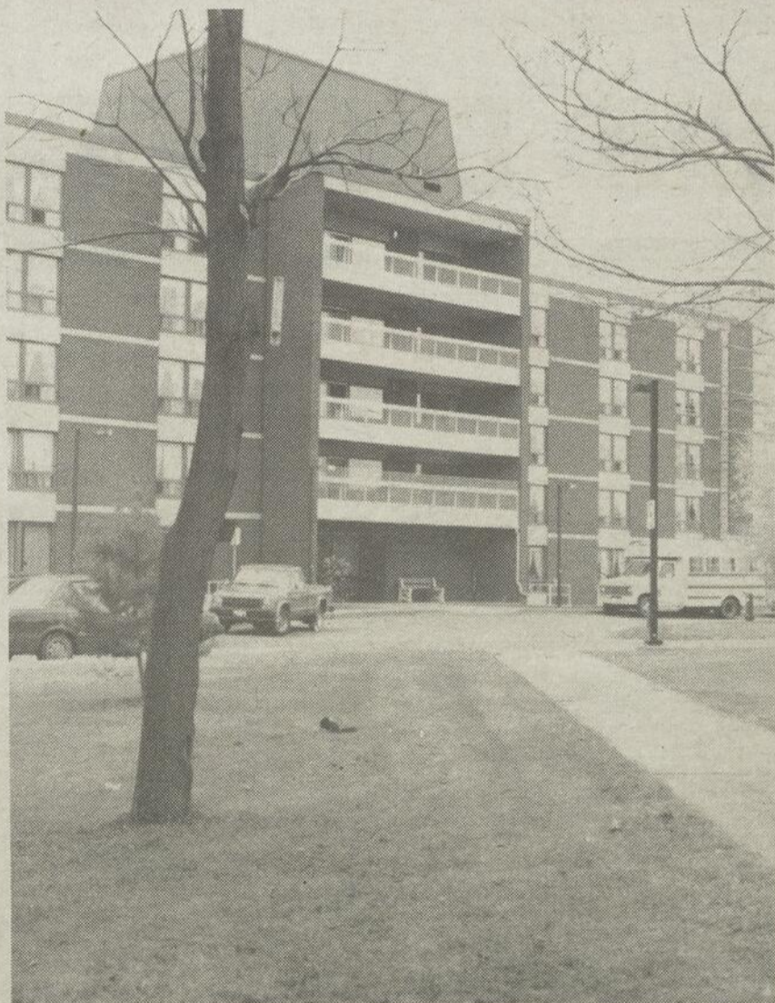
Il faudrait 5 millions $ pour rendre le Centre d'hébergement conforme aux besoins actuels.
