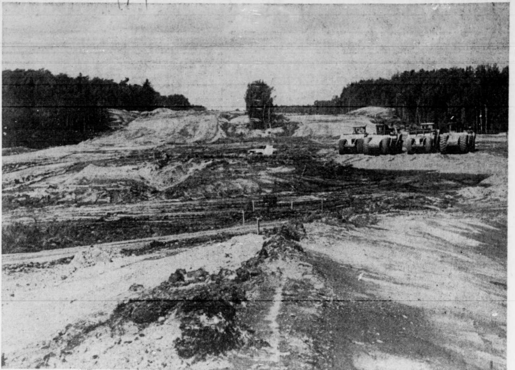
L'autoroute de la Beauce attend le pavage.
