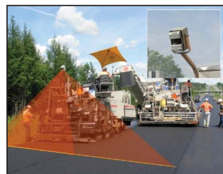
Figure 2 - Installation du scanneur sur un finisseur
