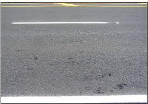
Photos 5 et 6 ESG-10 avec 3% de bardeau PC (bitume 40% mobilisable)
