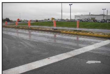
Figure 2 – Exemple d'application du planage fin – décontamination de surface
