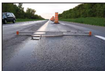
Figure 1 – Exemple d'application du planage fin – correction des ornières
