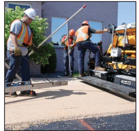
Figure 5 : Mise en place de l'enrobé fait avec un liant végétal au Québec à l'été 2009
