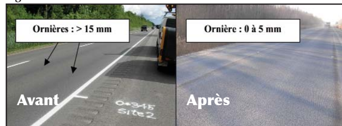
Figure 4 – Correction des ornières
