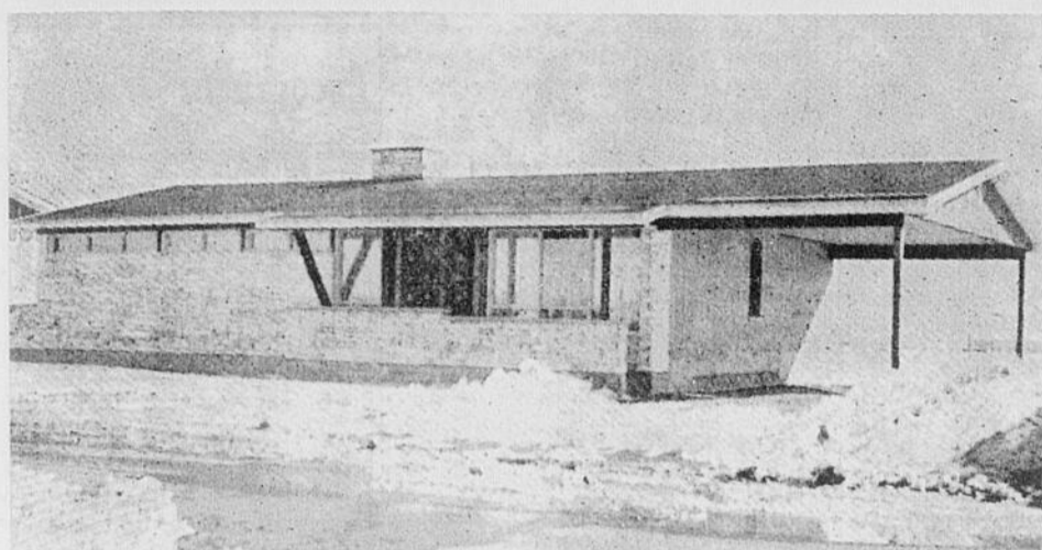
C'est M. Roger Bellemare, entrepreneur en couvertures qui a fait les travaux de revêtement de la maison de M. Paul Lessard de Louiseville. Cette maison est une Maison Laminex.
