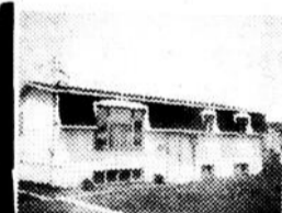
686, 4ième Rue, Rimouski-Est. Bungalow, sous-sol aménagé. Prix réduit.
