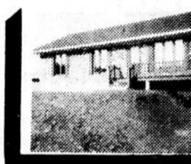
268 Des Eboulis, Ste-Odile - Bungalow, construction 1 an.
