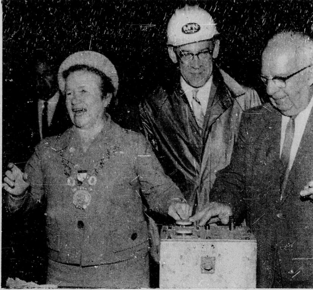
INAUGURATION DES TRAVAUX A EASTVIEW — Les maires d'Ottawa et d'Eastview, Mlle Charlotte Whitton et M. Oscar Perrier, pressent ici le bouton magique qui a fait exploser une charge de dynamite à l'entrée du tunnel, creusé à l'angle des rues Beechwood et Jolliet, inaugurant ainsi la construction d'égoûts pluviaux pour la ville d'Eastview. Ce projet est réalisé conjointement par Ottawa et Eastview et sera probablement terminé en novembre prochain. M. J.L. Dery, représentant M. William McNamara, président de la firme McNamara Quebec Ltd., assiste à la scène.
