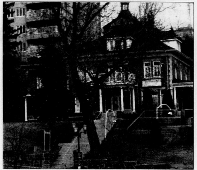
PERMIS - La démolition de la Maison Lévesque sera bientôt amorcée. (Photo Sylvain Dufour)
