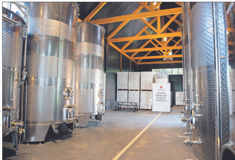
La cuverie contient désormais 22 cuves pour y accueillir les quelque 190 tonnes de raisins qui seront transformées cet automne.
