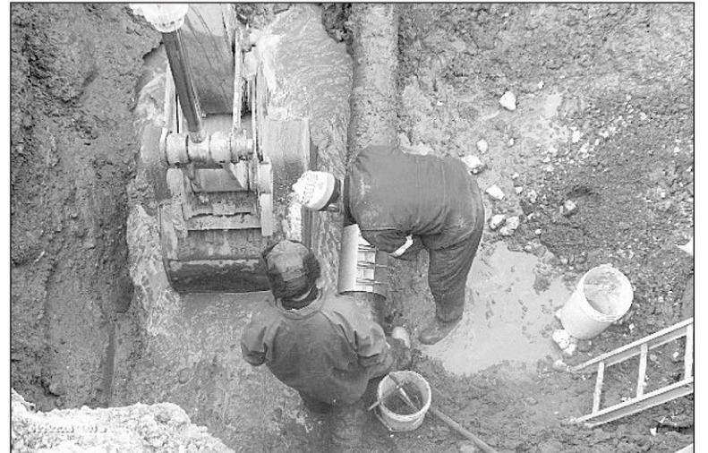
Les employés des Travaux publics ont réparé un tuyau défectueux dans le secteur de la rue Notre-Dame.
