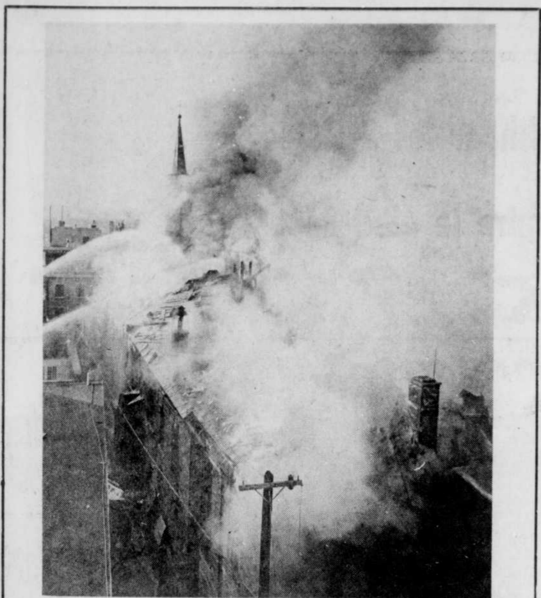
DUREMENT EPROUVÉE — Faute d'occupation, l'église St Patrick's fut durement éprouvée par les vandales et trois incendies majeurs. La photo nous donne un aperçu du dernier incendie à y avoir laissé sa trace.
