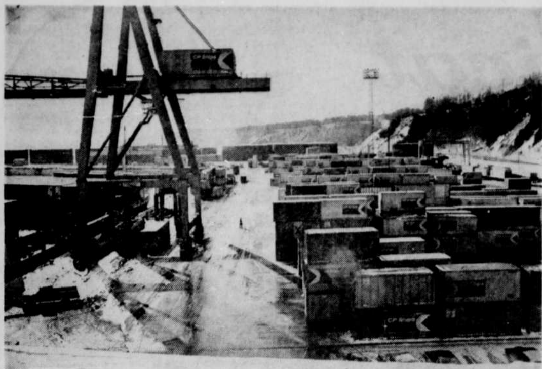
DES FOULONS AUX BATTURES — Le trafic des contenants-fret augmente toujours dans le havre local aussi bien avec le Canadien Pacifique, à l'Anse-aux-Foulons,
