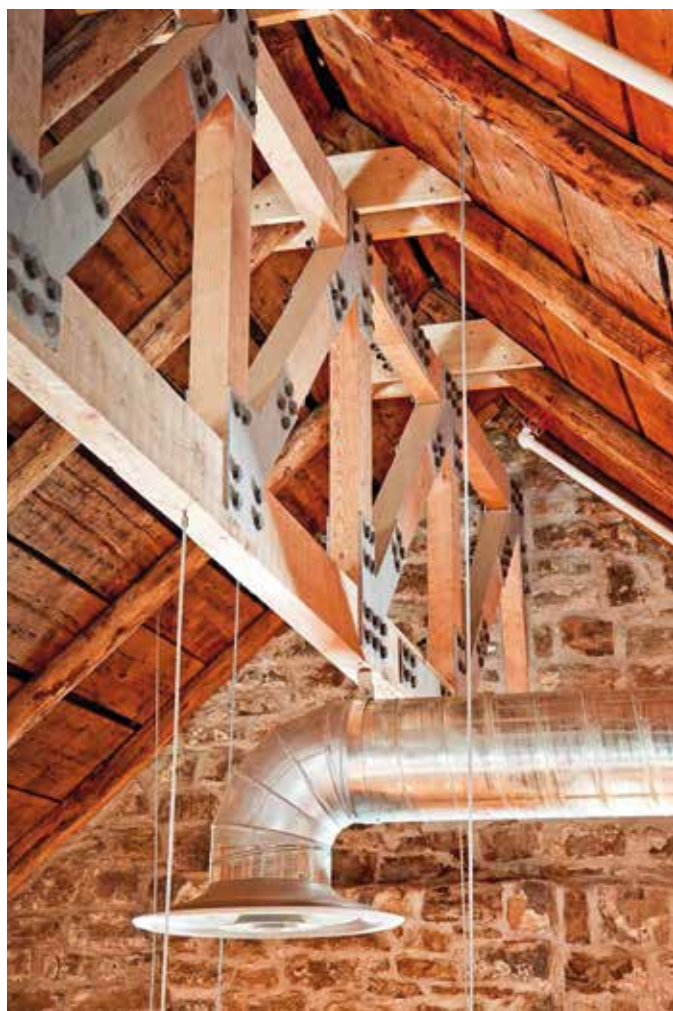
Pour la partie historique, on a tenu compte des façons de faire de l'époque, notamment pour le rejointoiement des murs de pierres. Comme il était impossible de faire passer des conduits et des tuyaux dans les planchers et les murs, on a opté pour des appareils d'éclairage et de ventilation apparents aux lignes épurées.
