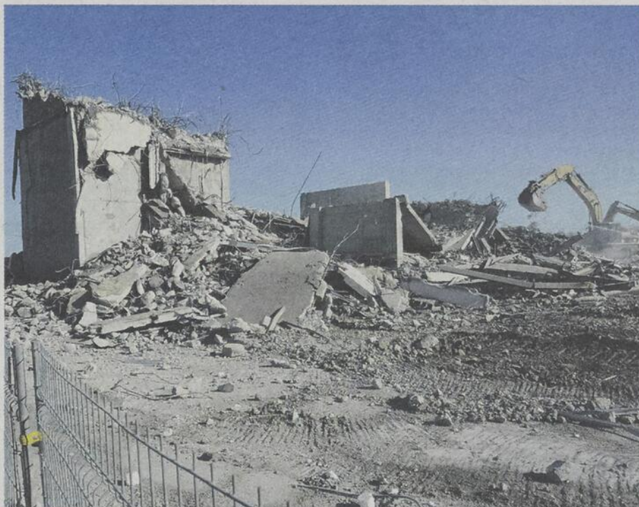
Des pelles mécaniques ont achevé le pharaonique chantier de démolition de l'Hôtel des Seigneurs. Photo François Larivière | Le Courrier ©
