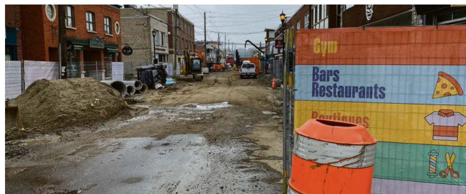
Un important chantier perdure à l'intersection des rues Augusta et du Prince.
