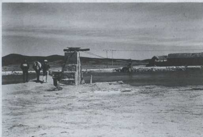
STATION DE JAUGEAGE CHUQUINA SUR LA RIVIÈRE DESAGUADERO
