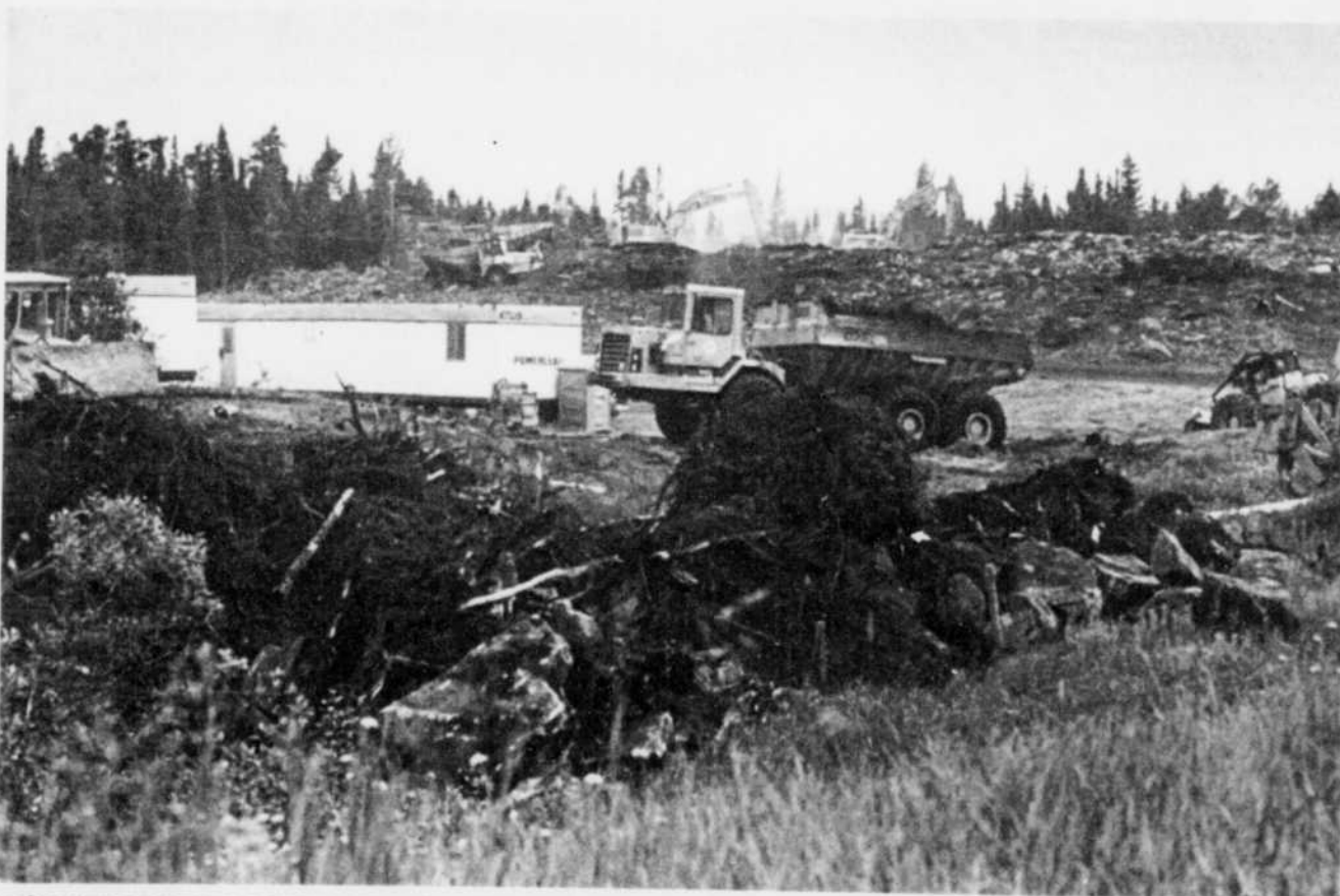
DÉBUT DES TRAVAUX - C'est lundi dernier qu'ont débuté les travaux de construction de la nouvelle usine d'épuration des eaux de la municipalité de Chicoutimi.
