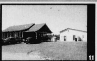
11 Bung + bâtisse pouvant être commerciale
