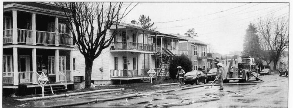
Le début d'incendie n'a fait que peu de dommages.
