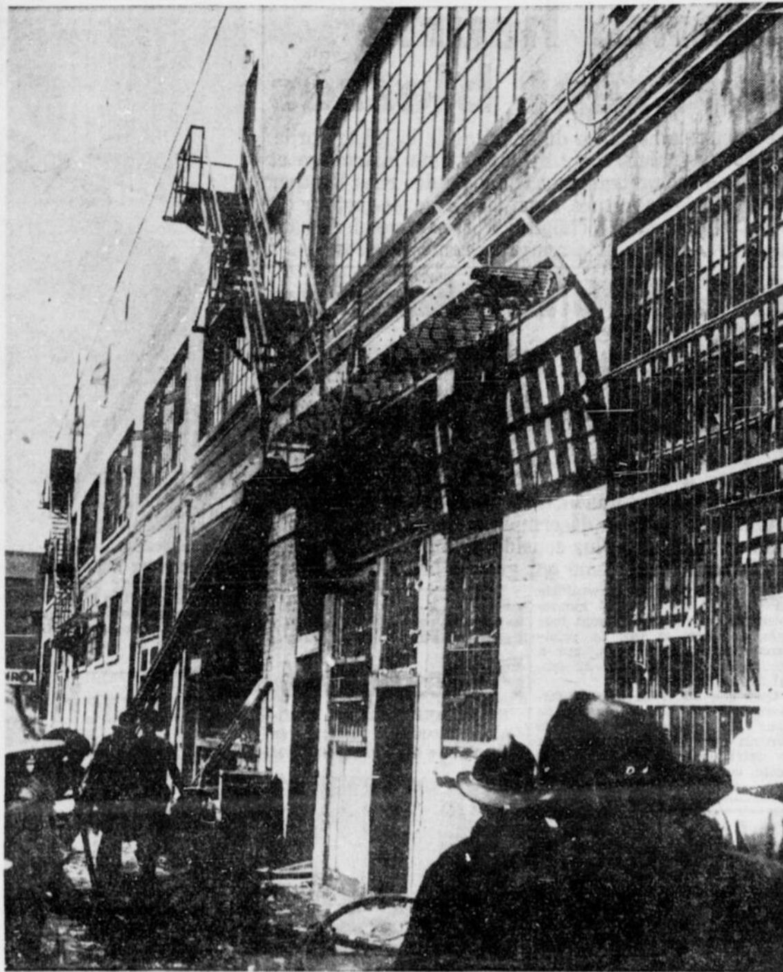
DEGATS DES FLAMMES AU MAGASIN STEINBERG — Des dommages évalués à plus de $10,000 ont été causés, hier, par un incendie d'origine encore indéterminée, qui se déclara dans l'une des succursales des magasins Steinberg, sise à 1636 ouest, rue Ste-Catherine. Cet instantané de l'artiste de la "Patrie" fait voir un groupe de pompiers peu après que l'on eut réussi à maîtriser les flammes dans le sous-sol de l'établissement.
