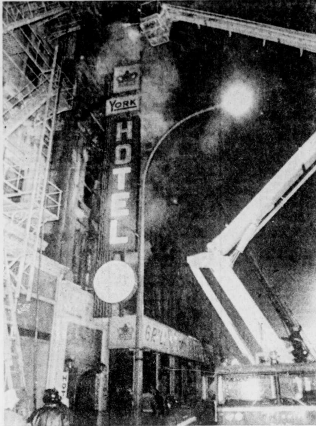
CINQ ALARMES — Les pompiers de Montréal ont dû utiliser leur échelle aérienne pour combattre un incendie qui s'était déclaré à l'hôtel York et qui a nécessité cinq alarmes, hier.
