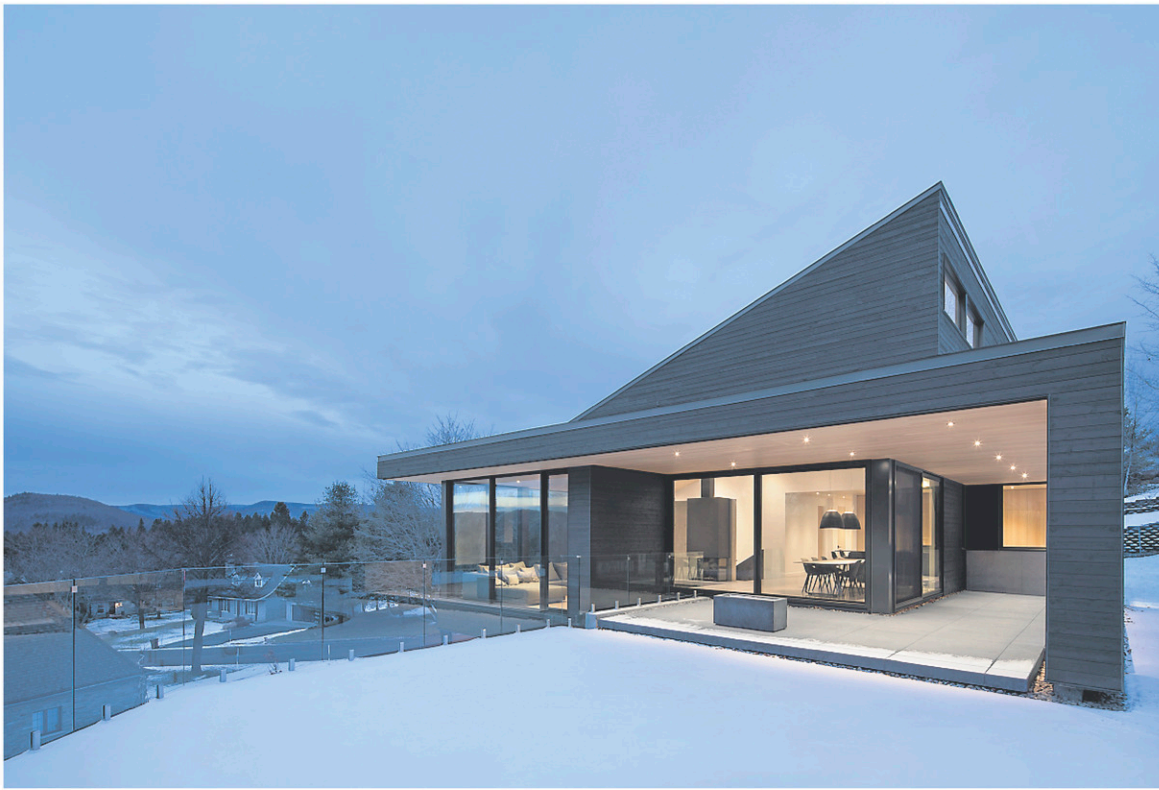
La Villa Vingt est bâtie sur un terrain en pente adjacent à la station de ski Le Relais, à Lac-Beauport. Elle est assise sur l'empreinte existante des fondations de l'ancienne maison des clients.
