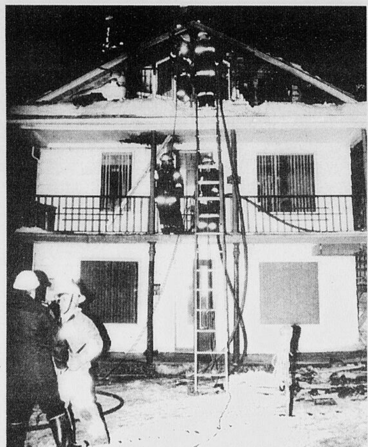
INCENDIE — Un incendie a fait rage au 677 de la rue Sainte-Anne vers 17h30 hier soir et a nécessité l'intervention d'une vingtaine de pompiers pour être éteint. Personne n'a été blessé, mais trois locataires ont été jetés à la rue. Hier, les pompiers ignoraient toujours les causes exactes de l'incendie.
