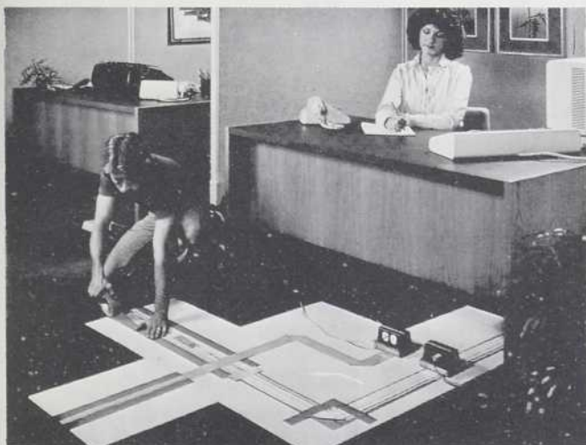
Un système de distribution électrique sous vos carreaux de tapis.
