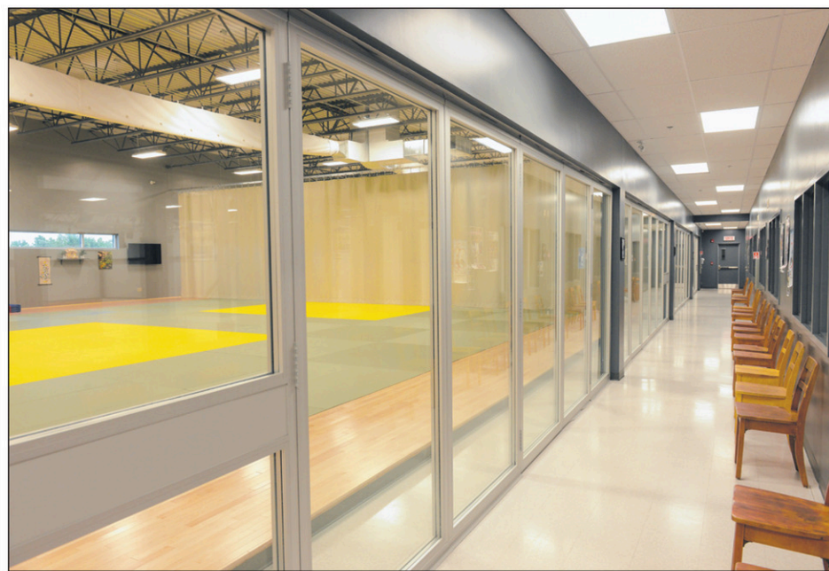
Une aire d'attente a été installée le long du dojo.
