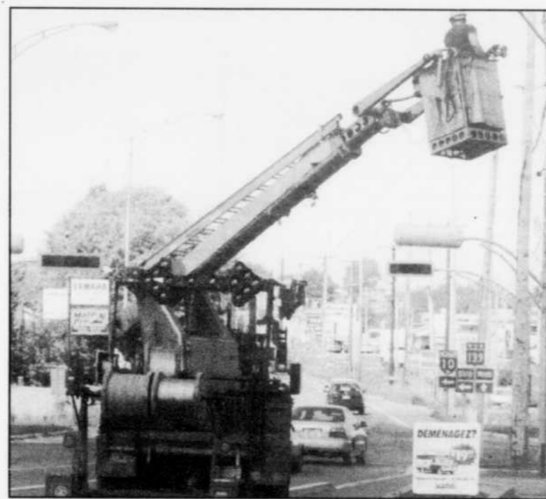
Les travaux entrepris depuis lundi sur la rue Dufferin doivent absolument être terminés cette année, sans quoi la municipalité perdra la subvention qui lui est promise dans le cadre du programme sur les infrastructures.
