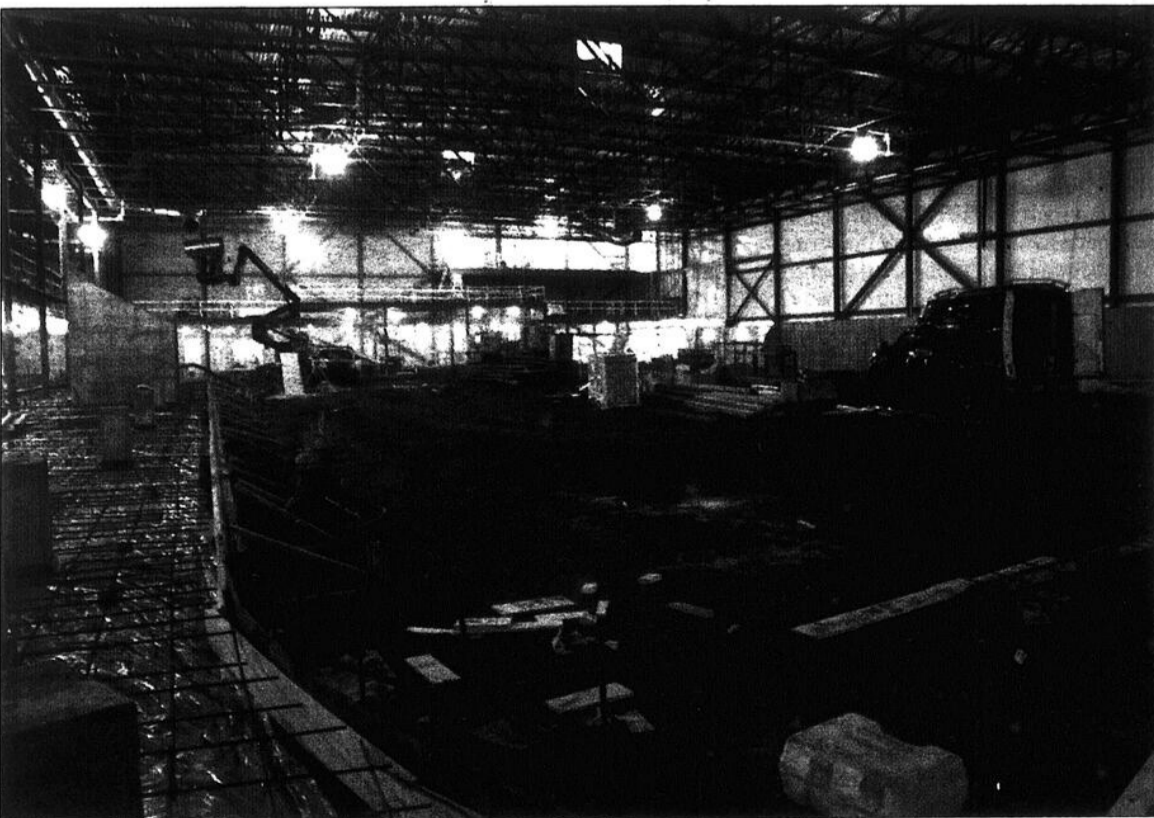
Le bétonnage du plancher situé autour de la patinoire débutait cette semaine.
