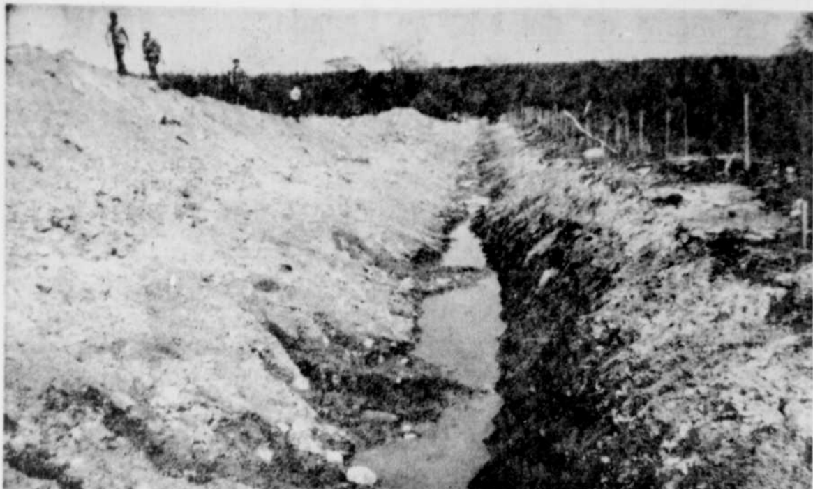
Usine d'épuration. — Les travaux de construction d'une usine d'épuration dans le village d'Omerville ont commencé hier matin. On voit sur cette photo la tranchée qui a été creusée à cet effet. Le contrat a été octroyé à M. Dorilas Grenier, de Sherbrooke, au coût de $33,000. (Photo Noël Goyette, Magog)
