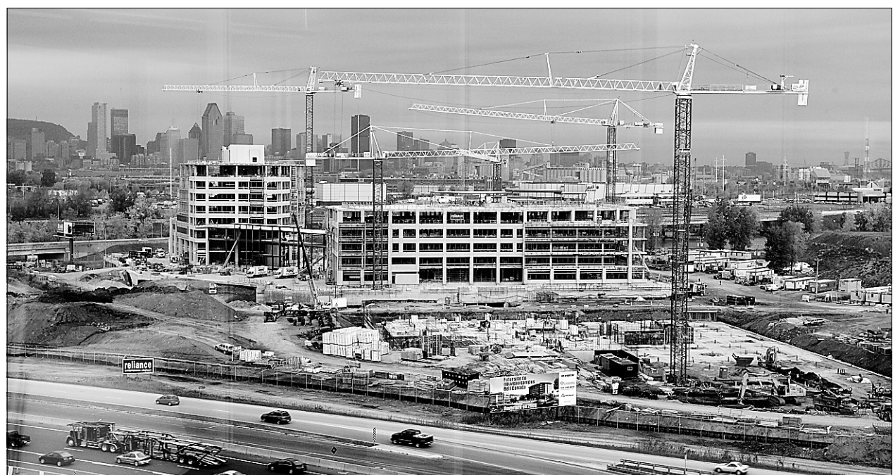
La construction du Campus Bell avance rapidement, près du pont Champlain, et doit être terminée pour septembre prochain. Sur la photo, une vue du chantier le 18 octobre dernier.
