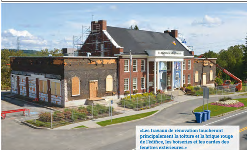
«Maison des Bâisseurs subit une belle cure de rénovation de son revêtement en briques rouges et de sa toiture.» (Photos: Trium Media / Jacques La Haye)
