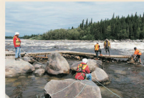
Travaux d'aménagement au site de Smokey Hill
