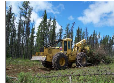
Travaux exécutés par une entreprise cri de Mistissini
