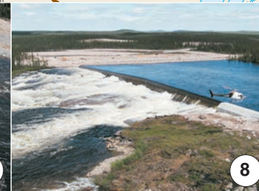
Seuil du PK 170
