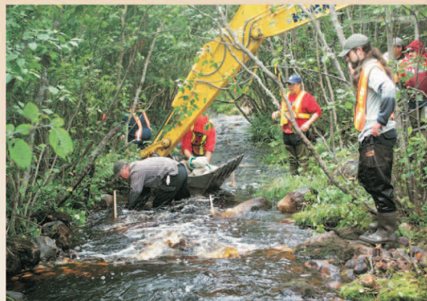
Aménagement d'une frayère à ombre de fontaine
