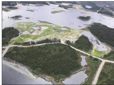
Aménagement d'un milieu humide en bordure du bief Rupert aval
