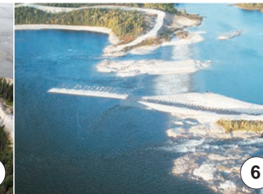
Seuil du PK 290
