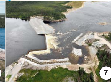
Seuil du PK 223
