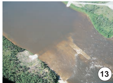
Tapis en enrochement du PK 20,4
