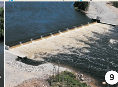
Seuil du PK 110,3
