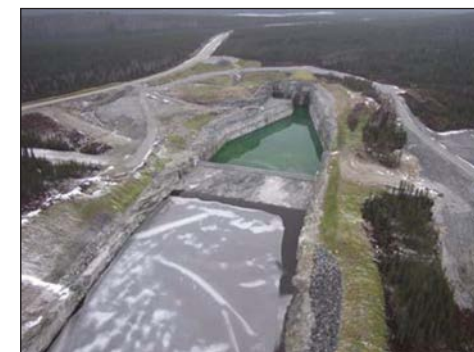
Ensemencement des aires touchées autour du tunnel de transfert Tommy-Neeposh
