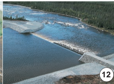
Seuil du PK 33
