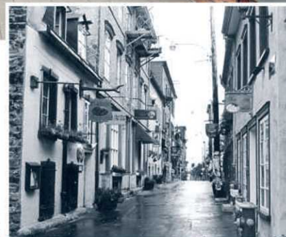
Quartier Petit Champlain, avant la restauration
