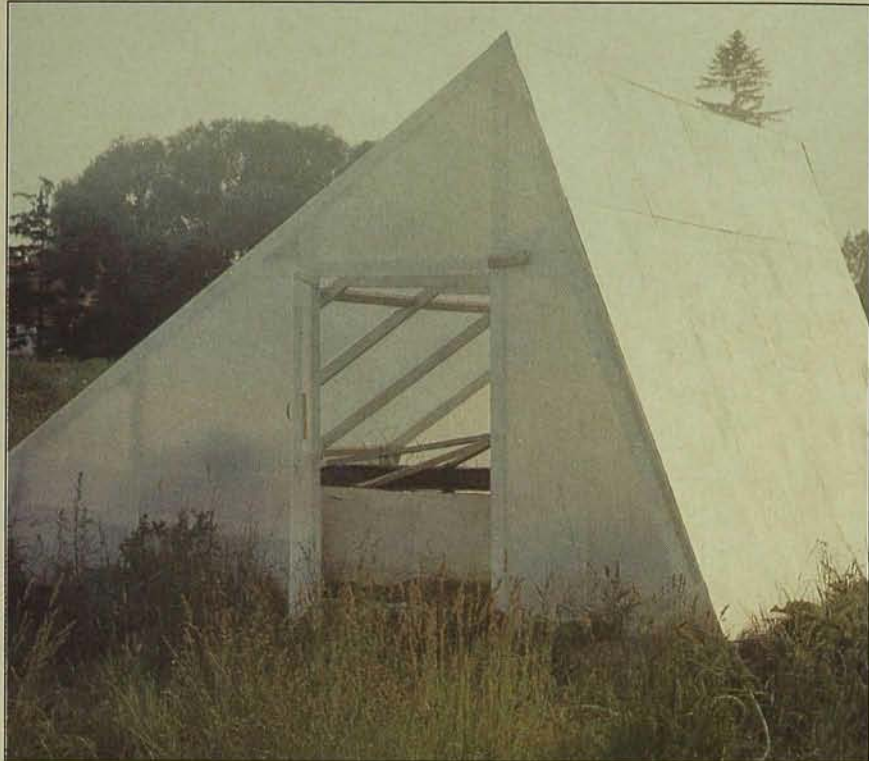
Grâce à sa forme peu conventionnelle, la serre Brace est très bien adaptée au climat québécois.
