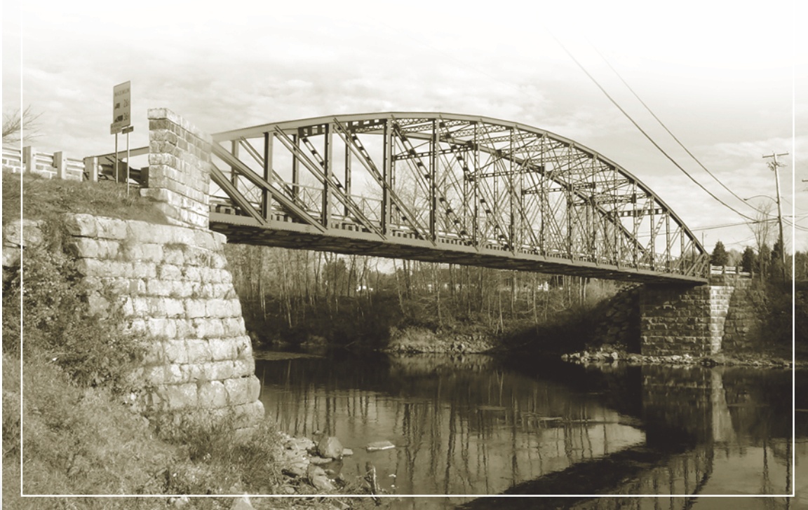
IPP de 37 : Pont Clark de Saint-Gabriel-de-Valcartier (Capitale-Nationale), type parabolique Macquet restauré en 2001. Mis en place sur la rivière Jacques-Cartier par la Dominion Bridge en 1892.
