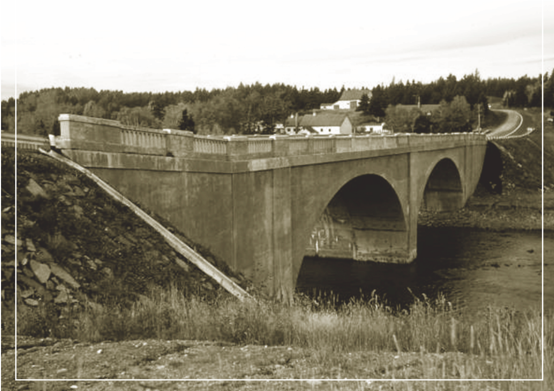
IPS de 66 : Pont Bergeron, type arc à tympan rigide construit en 1931 sur la route 132 à Grand-Métis (Bas-Saint-Laurent).
