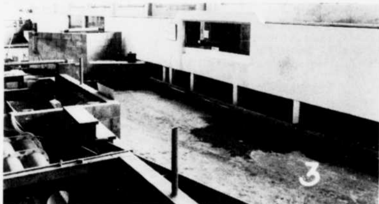
C'est dans ce canal, long de 129 pieds, que les chercheurs du Laboratoire d'hydraulique Lasalle simulent des vagues de tempête. Il est équipé d'un ventilateur qui permet de reproduire toute une gamme de vitesses du vent et d'amplitudes de houle. Le modèle est à l'échelle 1/15.
