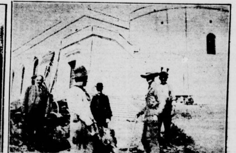
Le Frère André, surveillant l'exécution des travaux.
